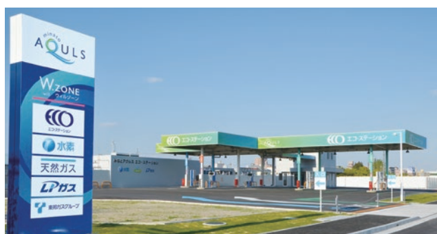
「みなとアクルス エコ・ステーション」。水素ステーションと天然ガススタンド、LPガススタンドを併設
