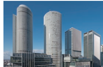
地域冷暖房を導入している JRセントラルタワーズを 中心とした名古屋駅周辺地区
